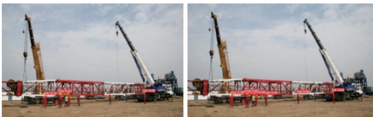
(a) 野外施工场景
